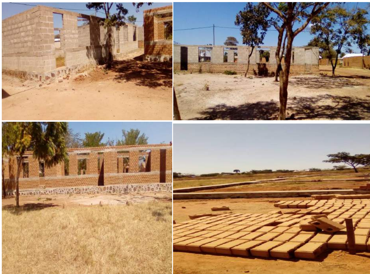
Muonekano wa ujenzi wa vyumba vya madarasa katika shule ya msingi Kasandalala
