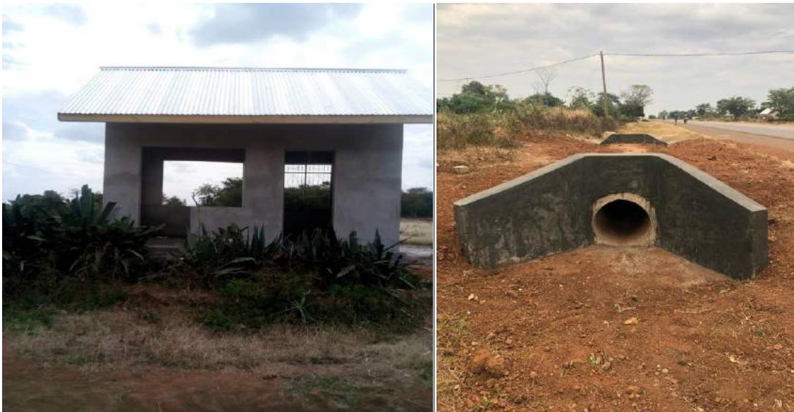
Muonekano wa ujenzi wa stendi ya mabasi katika Mji wa Masumbwe
