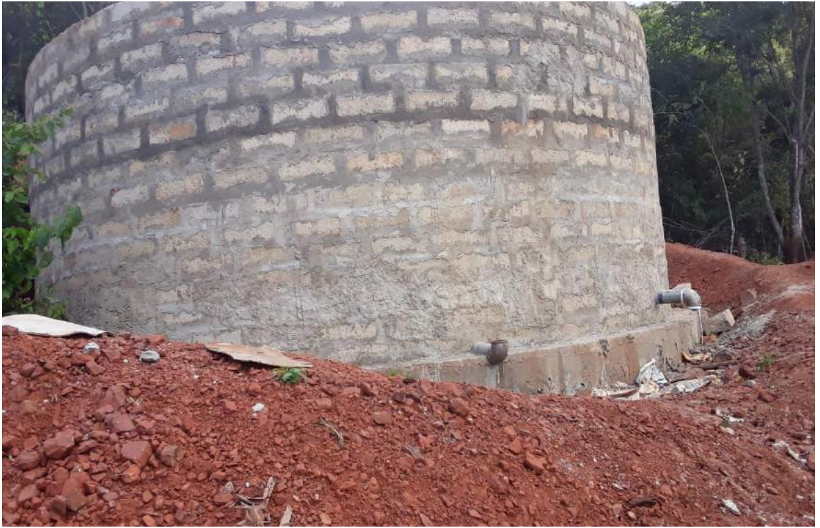
UJENZI WA TENKI LA MAJI KABANGA KATIKA MRADI WA MAJI KABANGA-NHOMOLWA
