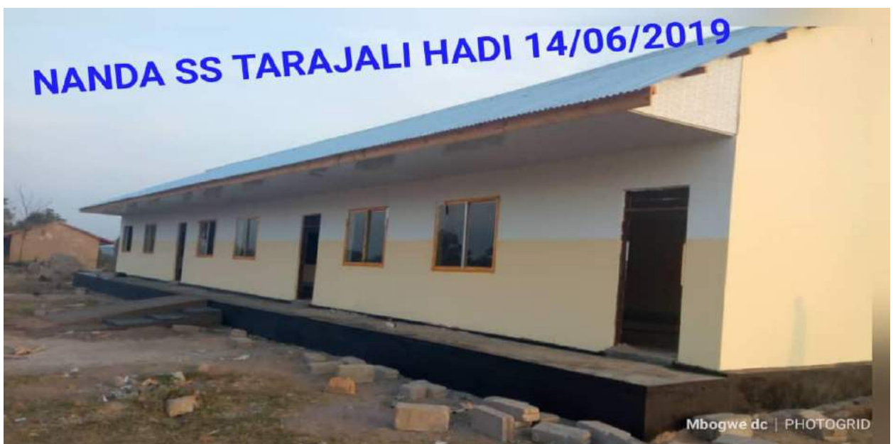
Muonekano wa vyumba vya madarasa shule ya sekondari Nanda
