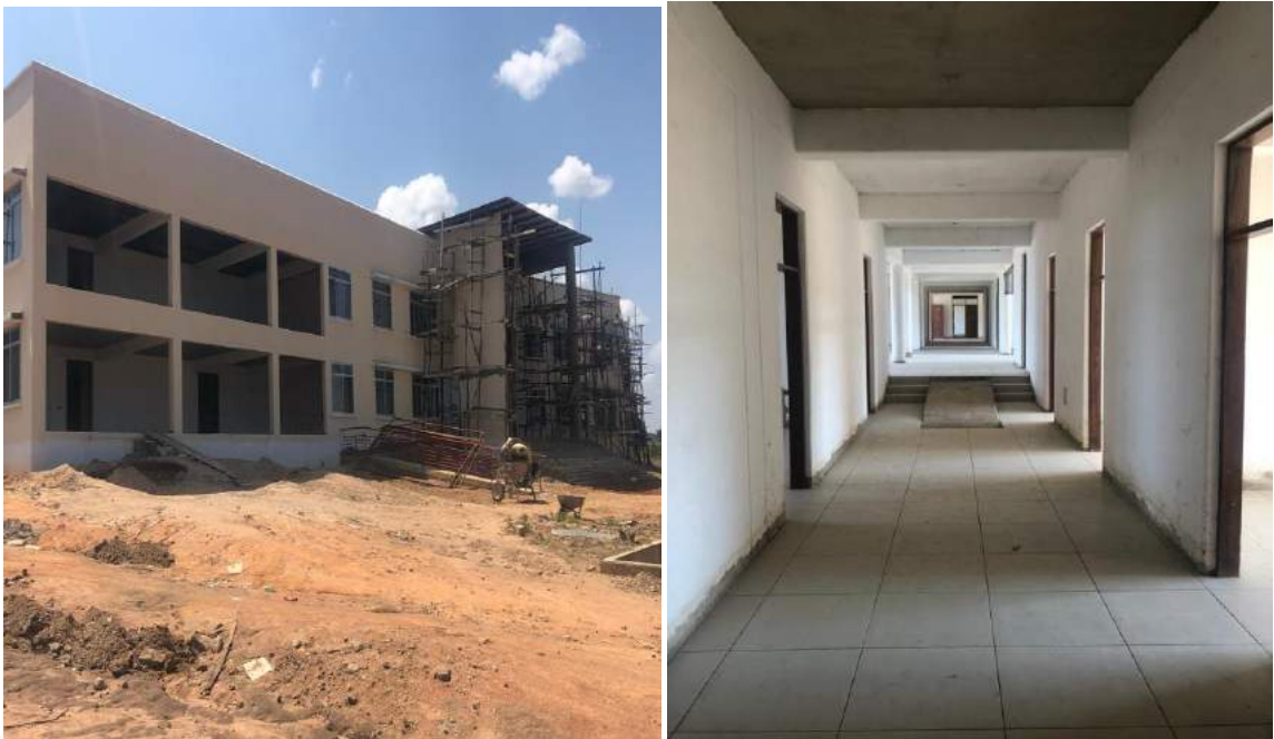
Muonekano wa Ujenzi wa Ofisi za Halmashauri ya Wilaya ya Mbogwe
