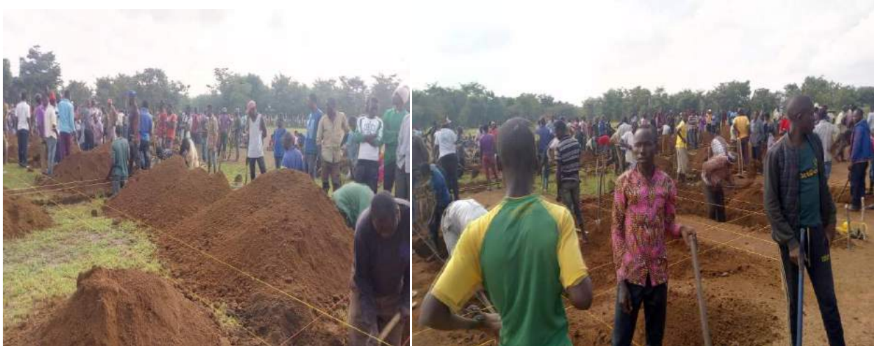
Wananchi wa kata ya Masumbwe wakishiriki kuchimba misingi ujenzi wa vyumba vya madarasa katika shule ya sekondari Nyakasaluma
