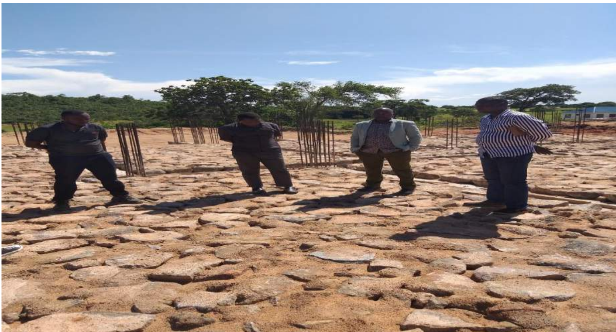
MUONEKANO WA HATUA YA UJENZI WA OFISI YA MKUU WA WILAYA YA MBOGWE
